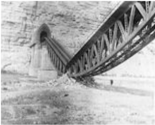
La caída de los dos tableros vista desde el techo de la boca del túnel ojival :
