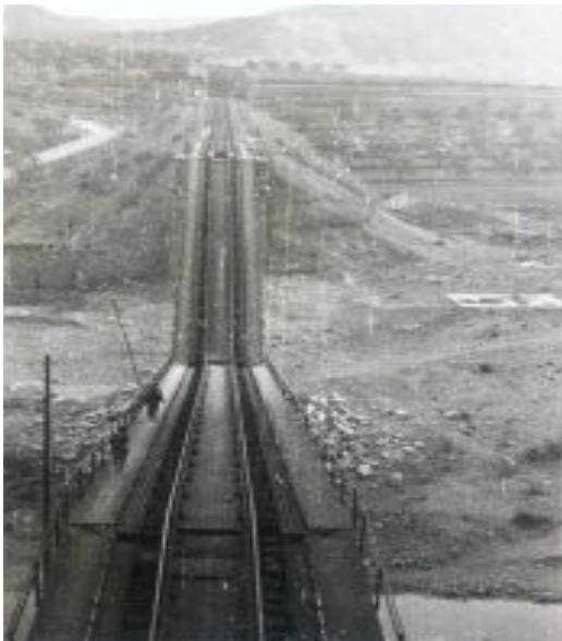
La caída de los dos tableros vista desde el techo de la boca del túnel ojival :
